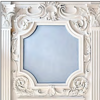
Noch leere Stuckrahmen im Hauptsaal
