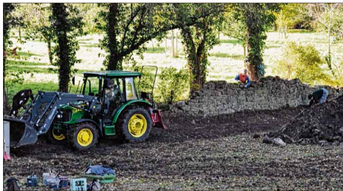
Mit schwerem Gerät und viel Muskelkraft wurde am Übergang zum Landschaftspark eine alte Mauer freigelegt.
