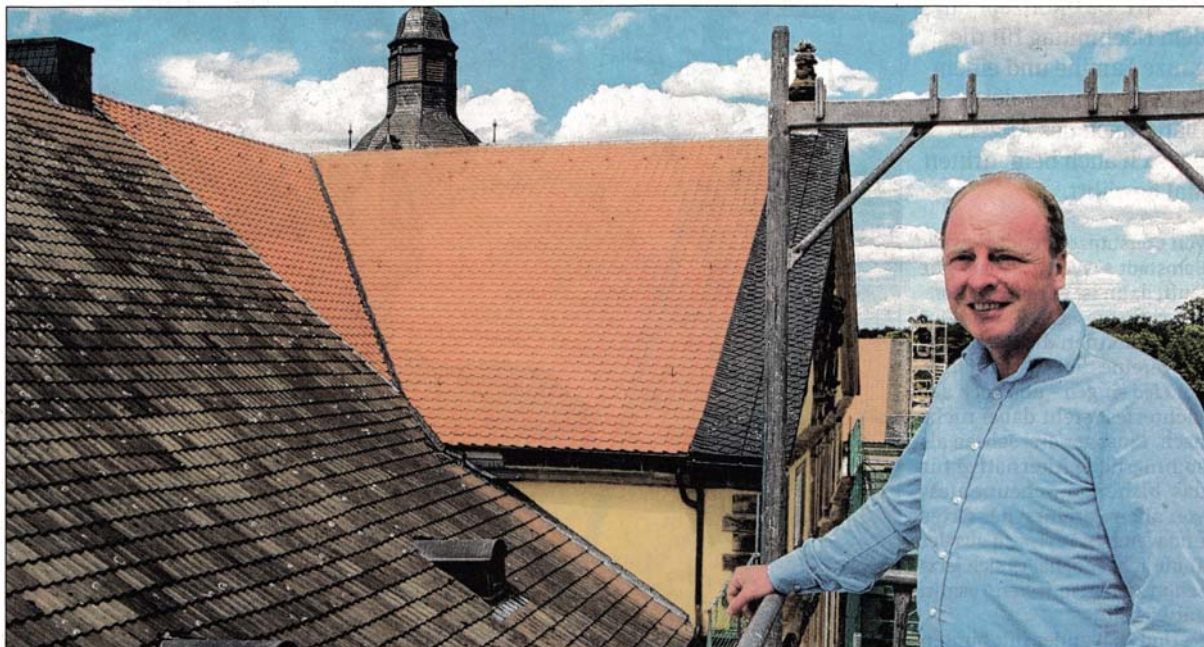
Holger Waldmann neben dem Dach des Hauptgebäudes. Deutlich zu erkennen ist der Unterschied zwischen Beton- und Tonziegeln. Foto: az
